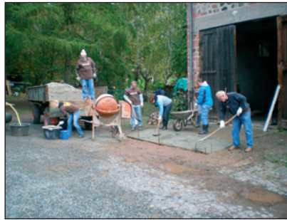
Reparatur der Einfahrt in die Getreidescheune mit Mitarbeitern von UPS Mörfelden
